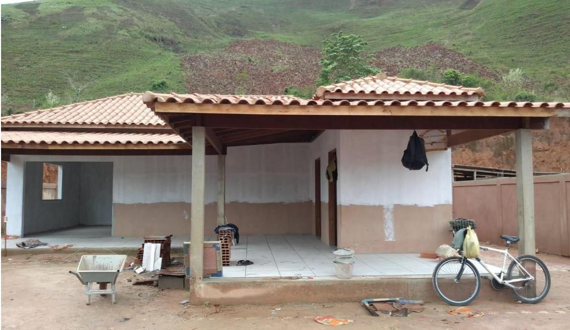
FECHAMENTO COM MURO DE 1,00 NA FRENTE DO TERRENO PARA FUTURA INSTALAÇÃO DE GRADIL E PORTÃO:
