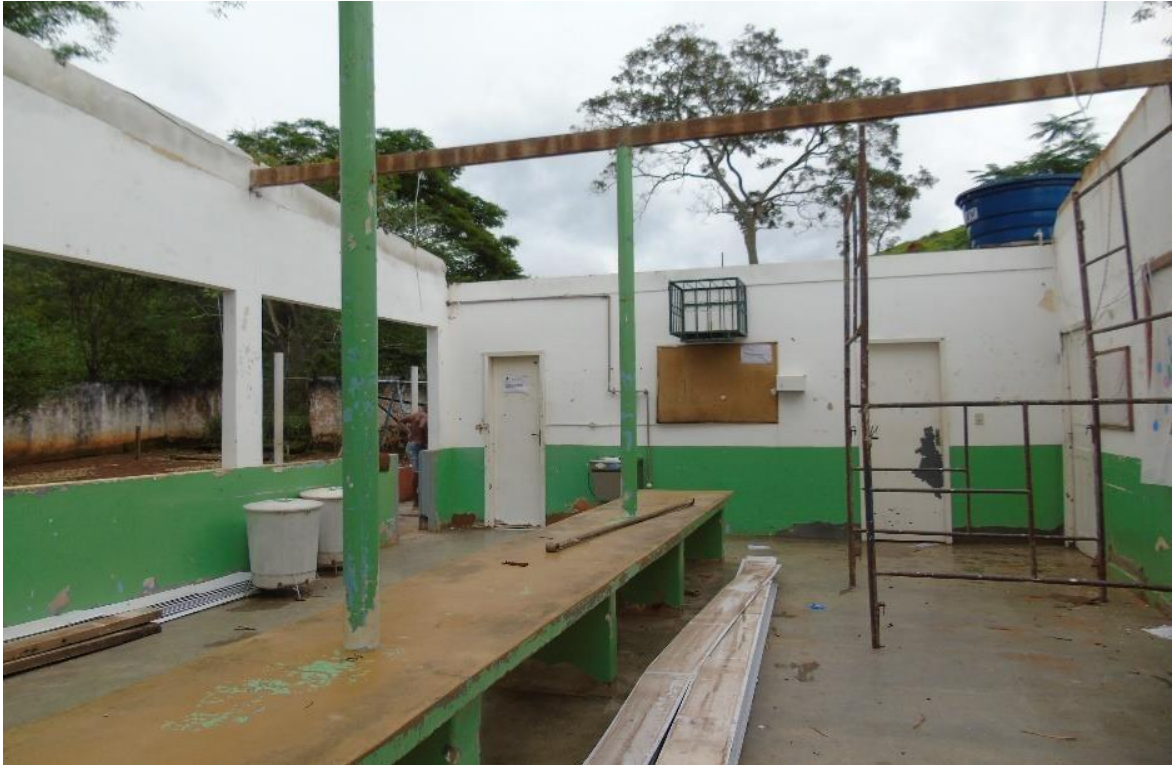
RETIRADA DO FORRO (PARTE INTERNA):
